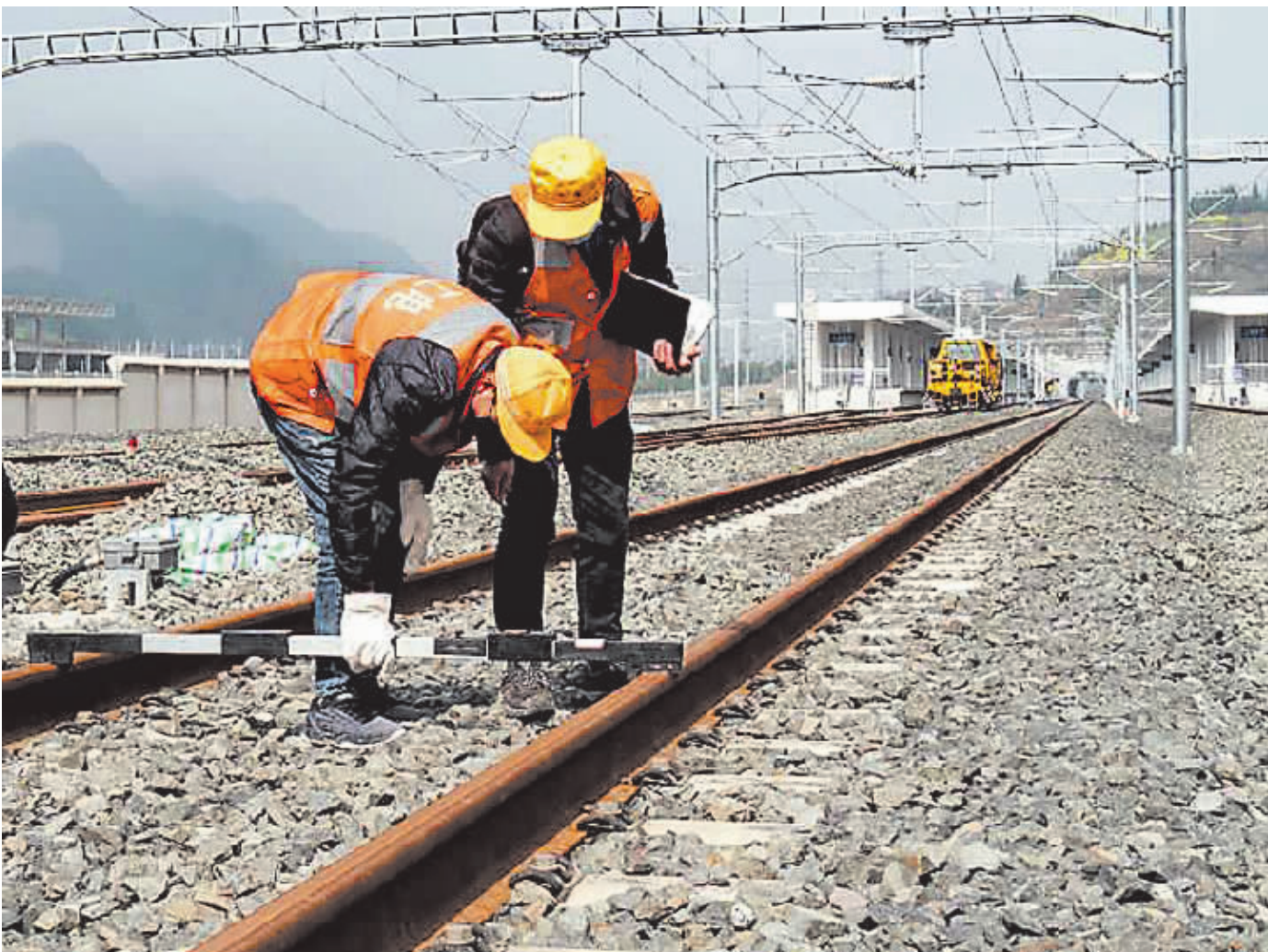
图为安六铁路静态验收现场。
