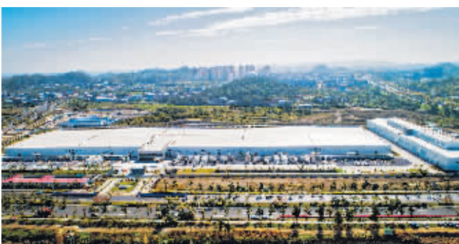
正在建设中的苹果iCloud中国(贵安)数据中心。
