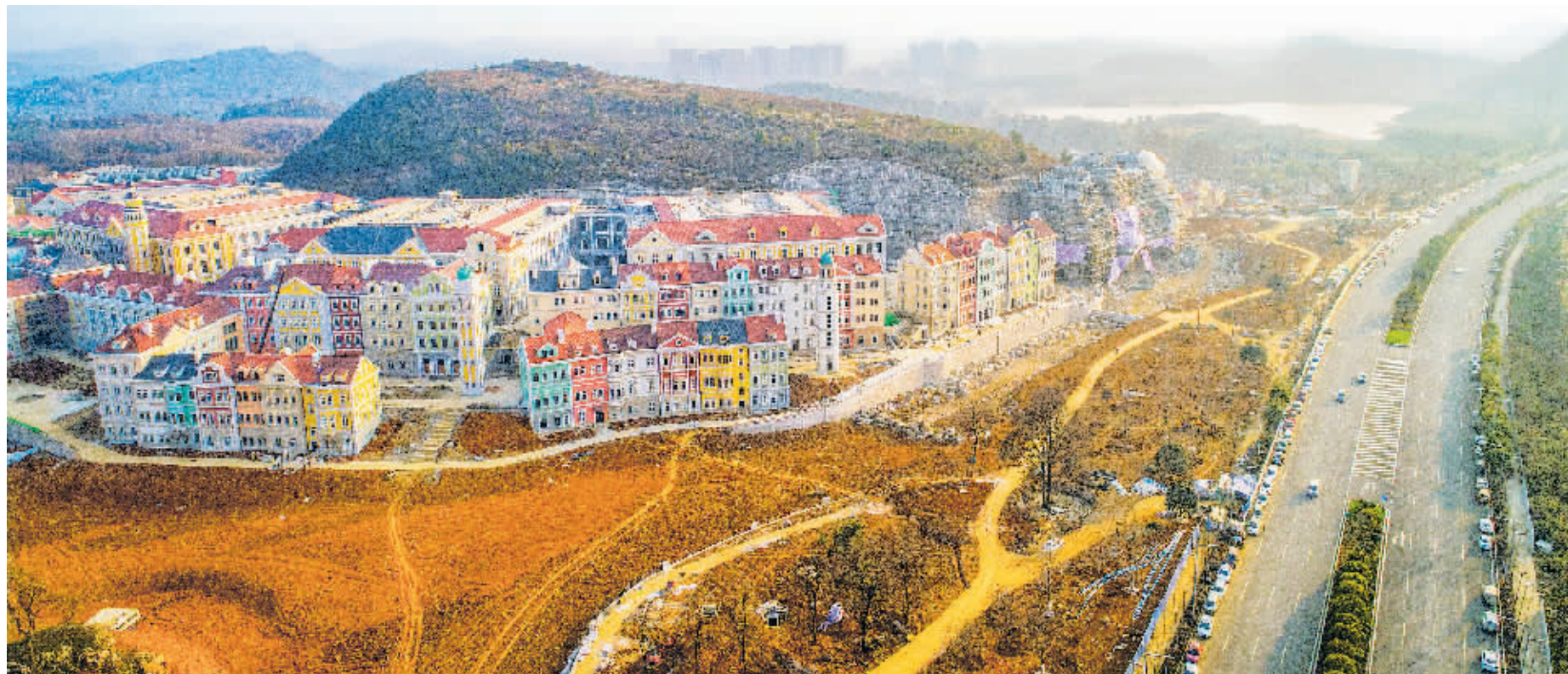
贵安华为云数据中心项目一角(1月4日报)。
