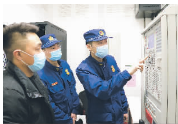
消防队员在重点企业开展消防安全检查。
