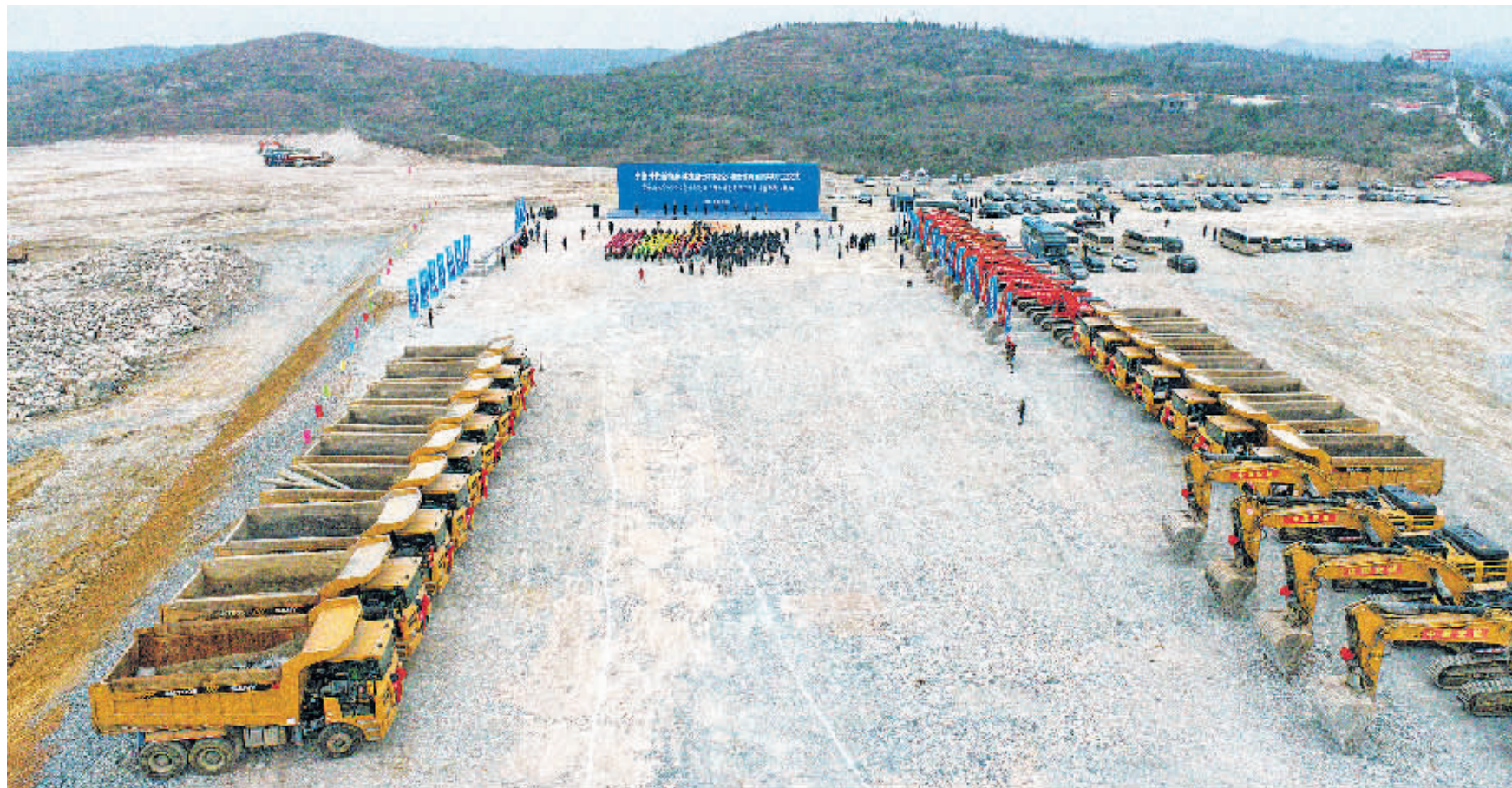
图为宁德时代贵州新能源动力及储能电池生产制造基地项目开工仪式现场。
