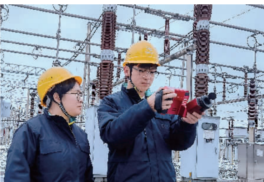
图为工作人员在变电站开展巡视。
