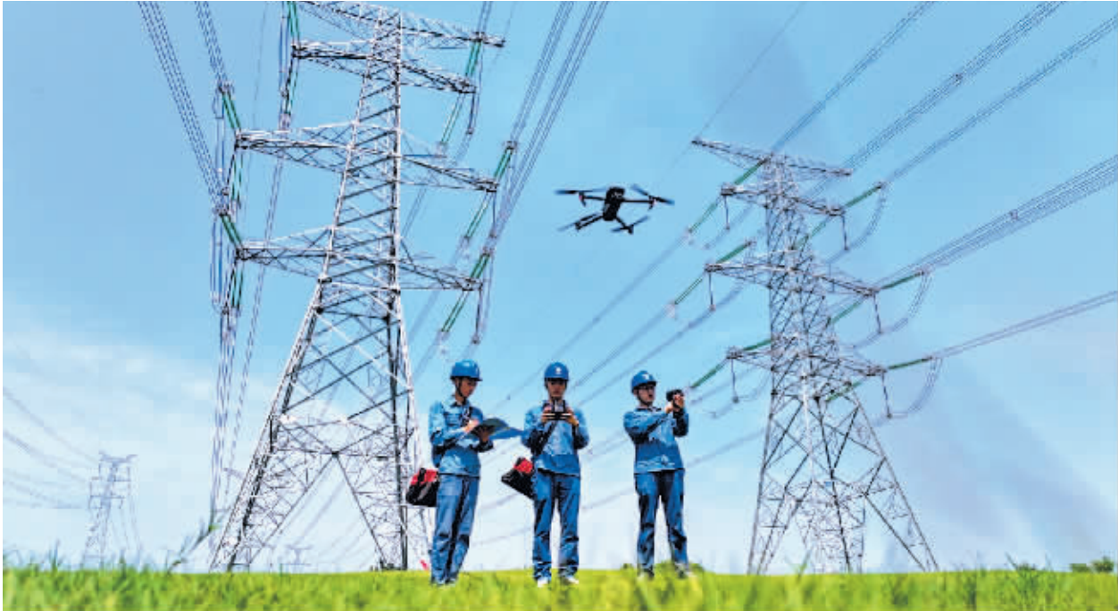
面对安徽、江苏持续高温,皖苏两省的电力工人联合对省际联络线及相关配电设施进行检修,并开展输电设备巡视检查。图为在安徽省滁州市南谯区,电力工人运用无人机对500千伏输电线路进行巡视检查(8月9日报)。
