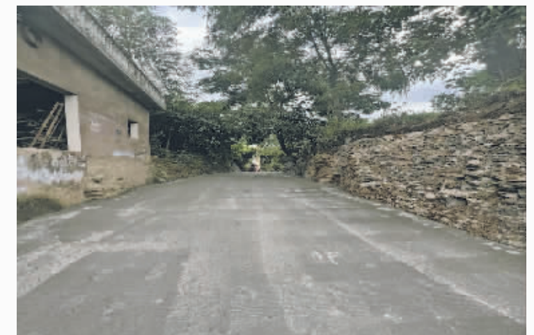
党武村修缮扩宽后的进村道路。
