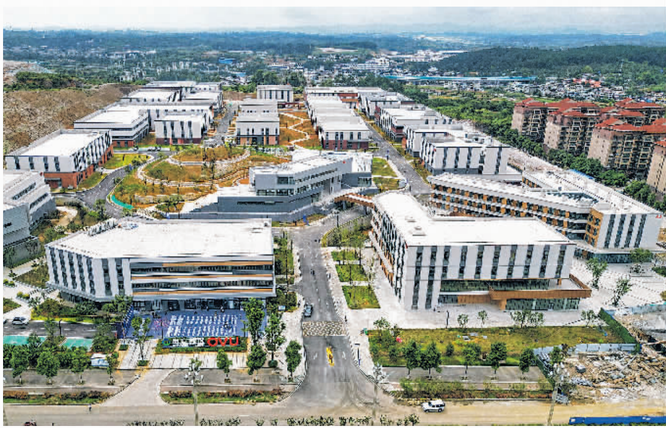
俯瞰东数西算贵安新区算力产业集群配套项目首开区·贵安新区机器人创新产业园。贵阳日报融媒体中心记者 石照昌 摄
