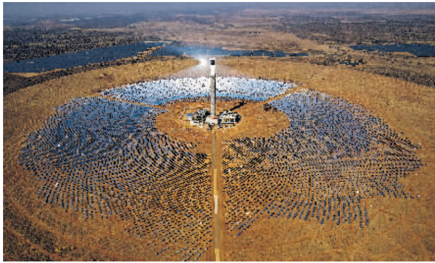
这是2024年8月20日在南非北开普省拍摄的南非红石100兆瓦塔式熔盐光热电站项目(无人机照片)。由中国电建集团山东电建三公司承建的南非红石100兆瓦塔式熔盐光热电站项目是撒哈拉以南非洲首个塔式熔盐光热电站项目,也是南非最大可再生能源投资项目之一。
