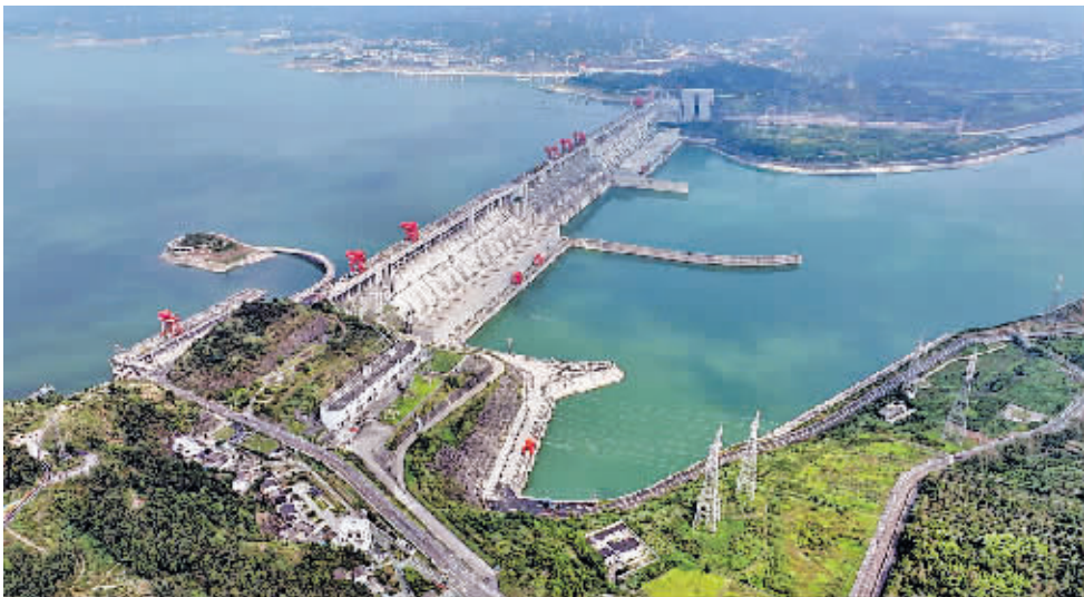
9月10日,三峡水库正式启动2024年175米蓄水。175米是三峡水利枢纽工程设计的正常蓄水位。三峡水库在每年汛末蓄水,在枯水期至次年汛前逐渐释放并腾出库容,以“蓄丰补枯”调度,为当年冬季和次年春季长江流域的航运、供水、生态、发电等需求提供有力保障。图为在湖北省宜昌市夷陵区三峡坝镇拍摄的三峡大坝(9月11日摄,无人机照片)。 新华社/傅真
