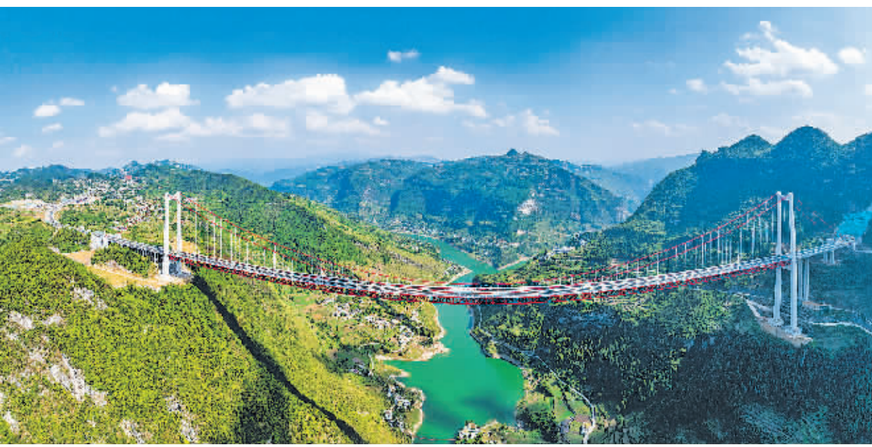
金仁桐高速桐梓河特大桥。
