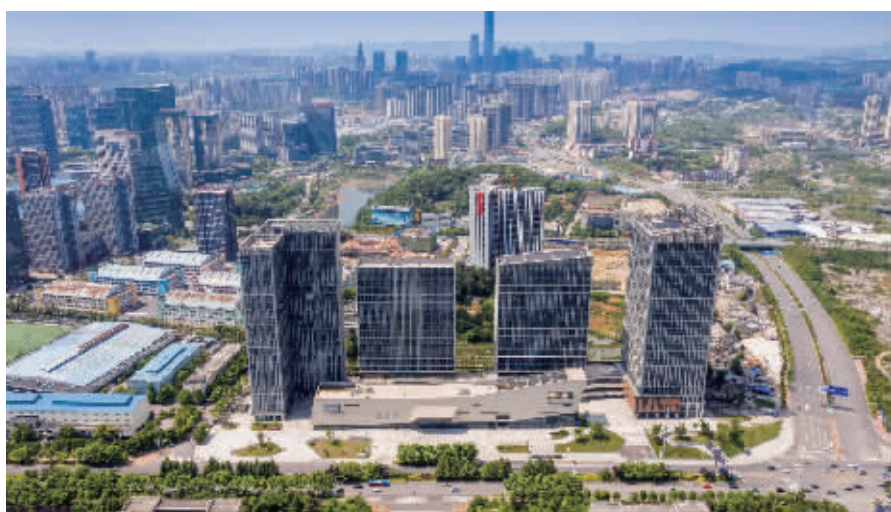
图为阳光城·启航中心项目。
