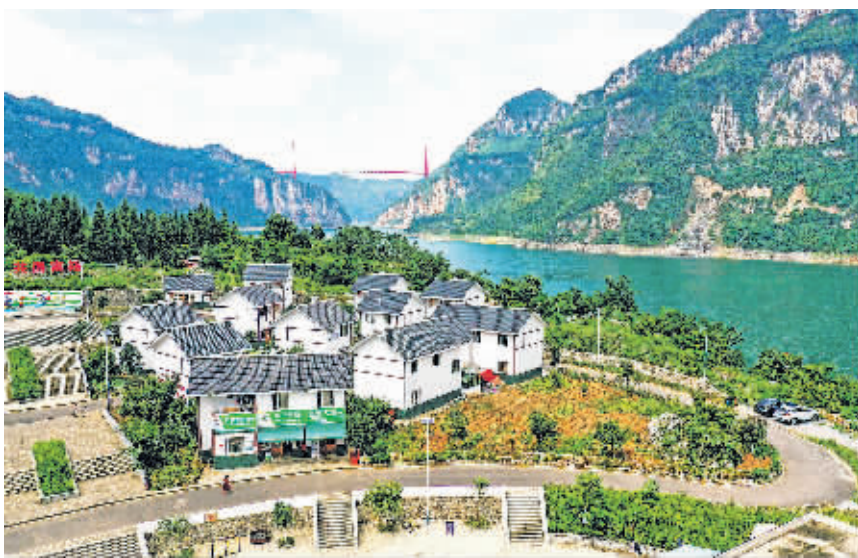
贵州省黔西市新仁苗族乡化屋村麻窝寨易地搬迁集中安置点（2021年7月24日摄，无人机照片）。 新华社/传真
