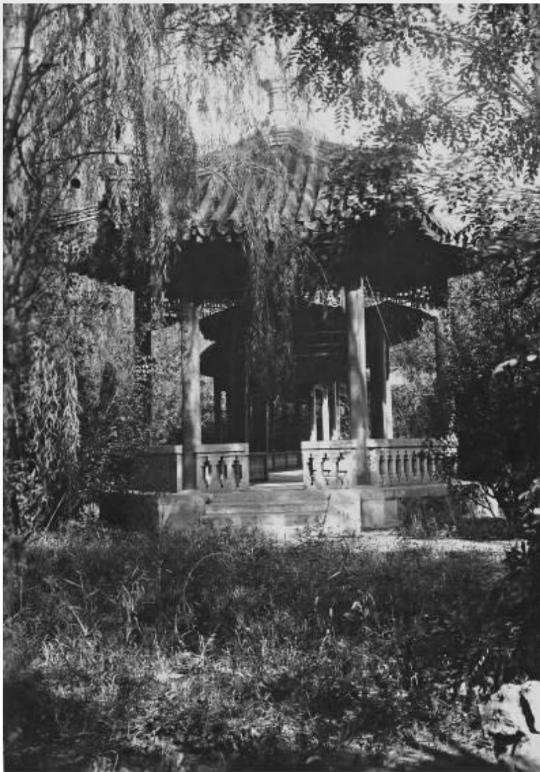
达园长廊两侧修建的六角亭中的一座。
