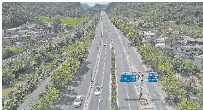
改造后的马场特大桥路段。
