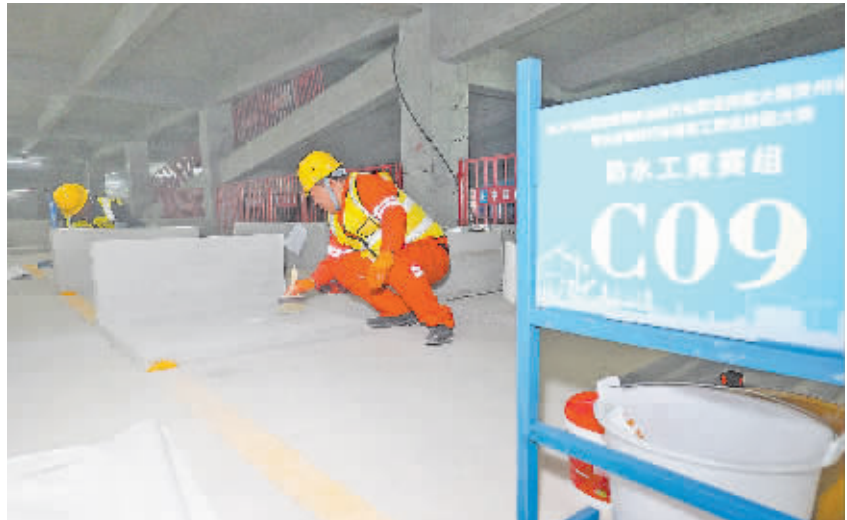
参赛选手在进行防水工程比赛。 贵阳日报融媒体中心记者 石照昌 摄
