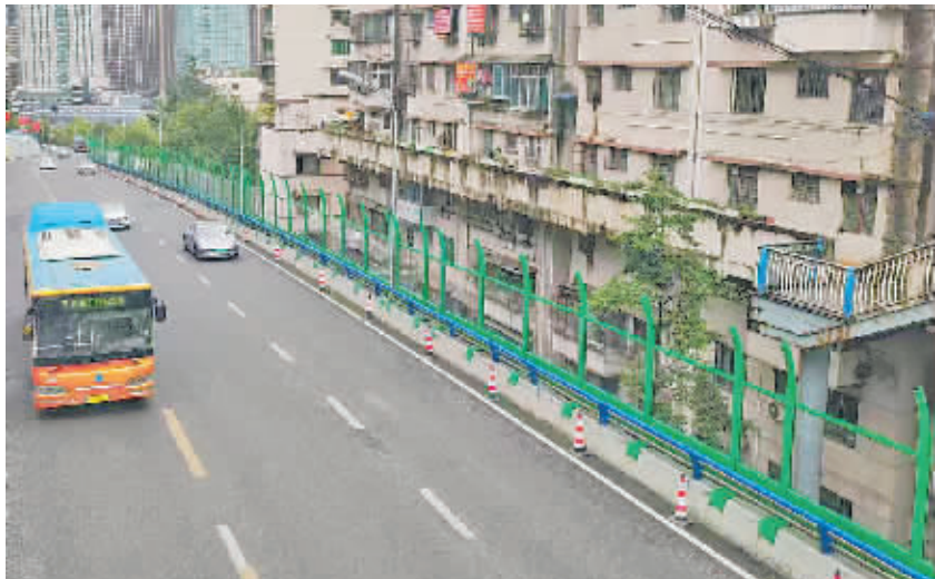
北京西路邻近海马冲隧道路段的旧隔声屏障拆除后,云岩区市政工程管理所已安装部分新的隔声屏障固定框架。
