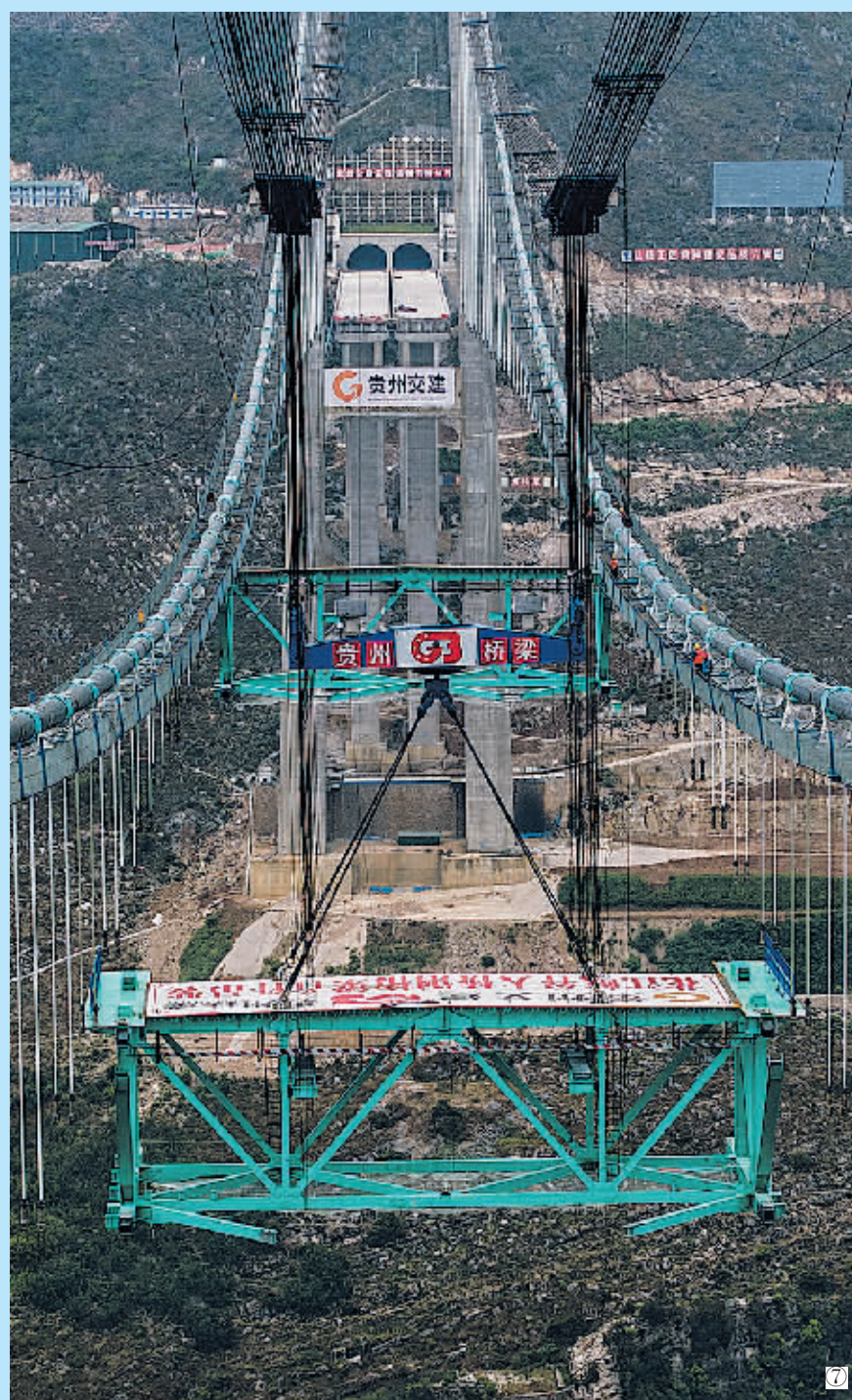
①贵州、云南交界处的杭瑞高速北盘江大桥（2023年8月16日摄，无人机照片）。
