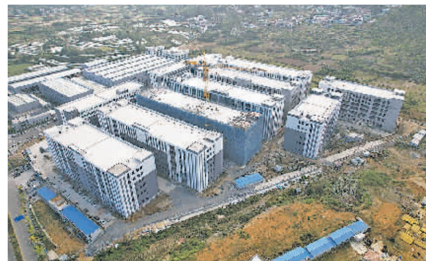
俯瞰燕楼工业园区新芯工业及配套基础设施建设项目。
