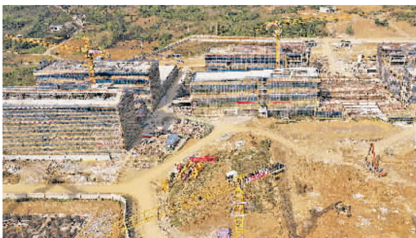
建设中的初中部(摄于11月19日)。
