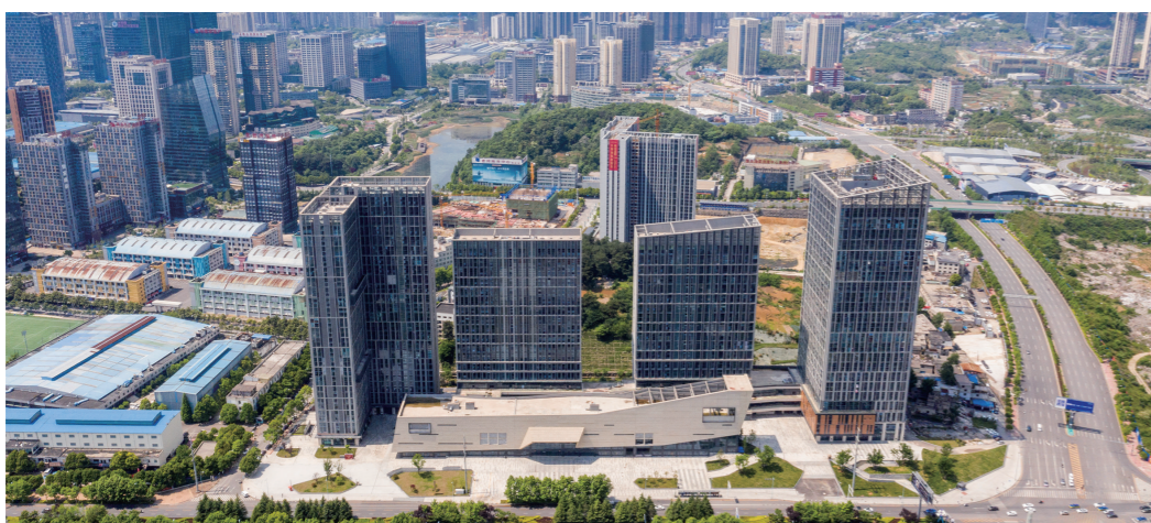
图为阳光城·启航中心项目。
