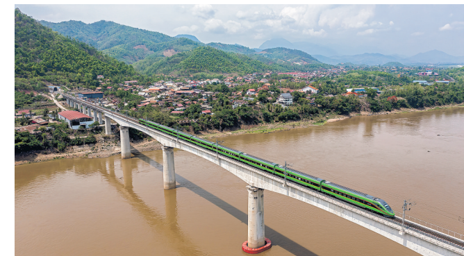
2023年5月28日,中老铁路客运列车通过老挝琅勃拉邦湄公河特大桥(无人机照片)。
