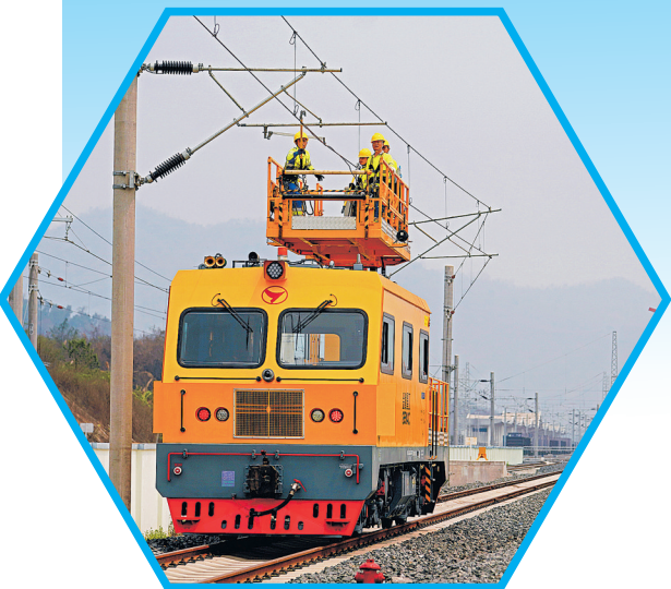
2023年4月17日,琅勃拉邦维保管理中心的工人在老挝琅勃拉邦站附近进行接触网维修保养演练。
