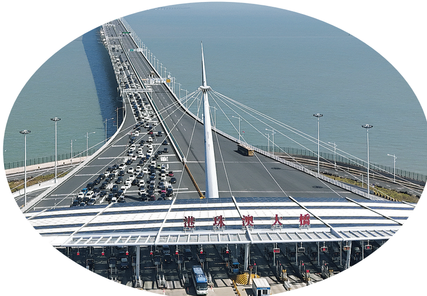
港珠澳大桥桥头(2024年2月12日摄,无人机照片)。
