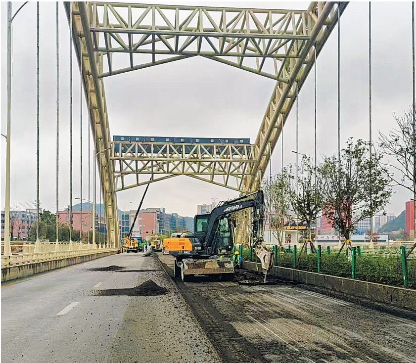
龙凤大桥维修施工现场。
