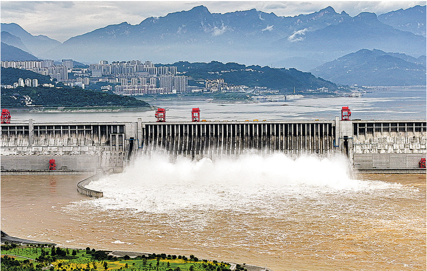
长江三峡枢纽工程(2024年7月20日摄,无人机照片)。
