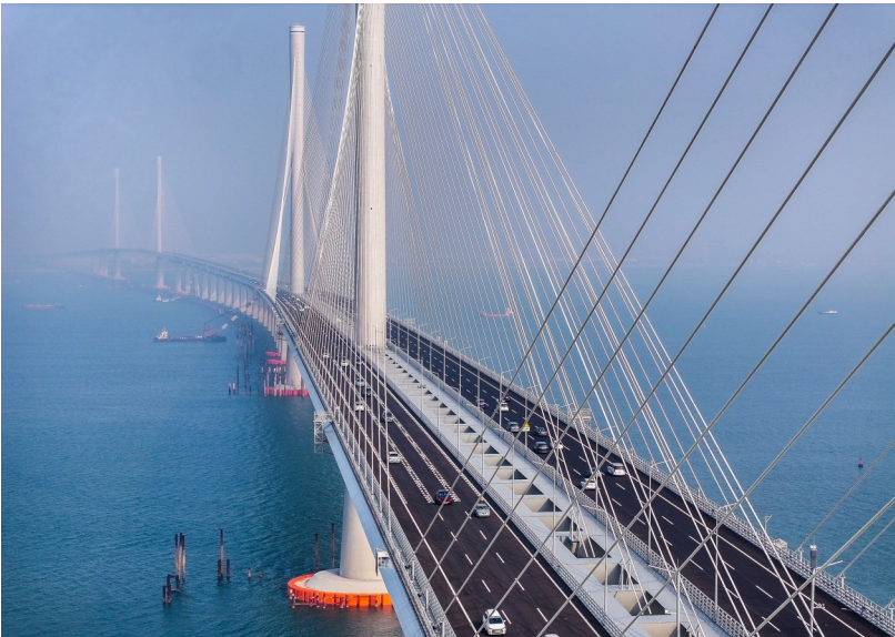
12月11日,黄茅海跨海通道正式通车后,车辆行驶在黄茅海大桥上(无人机照片)。 新华/传真
