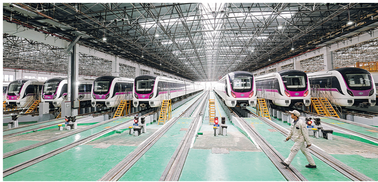
轨道交通S1线皂角坝车辆段,电客车整装待发。 贵阳日报融媒体中心记者 石照昌 摄
