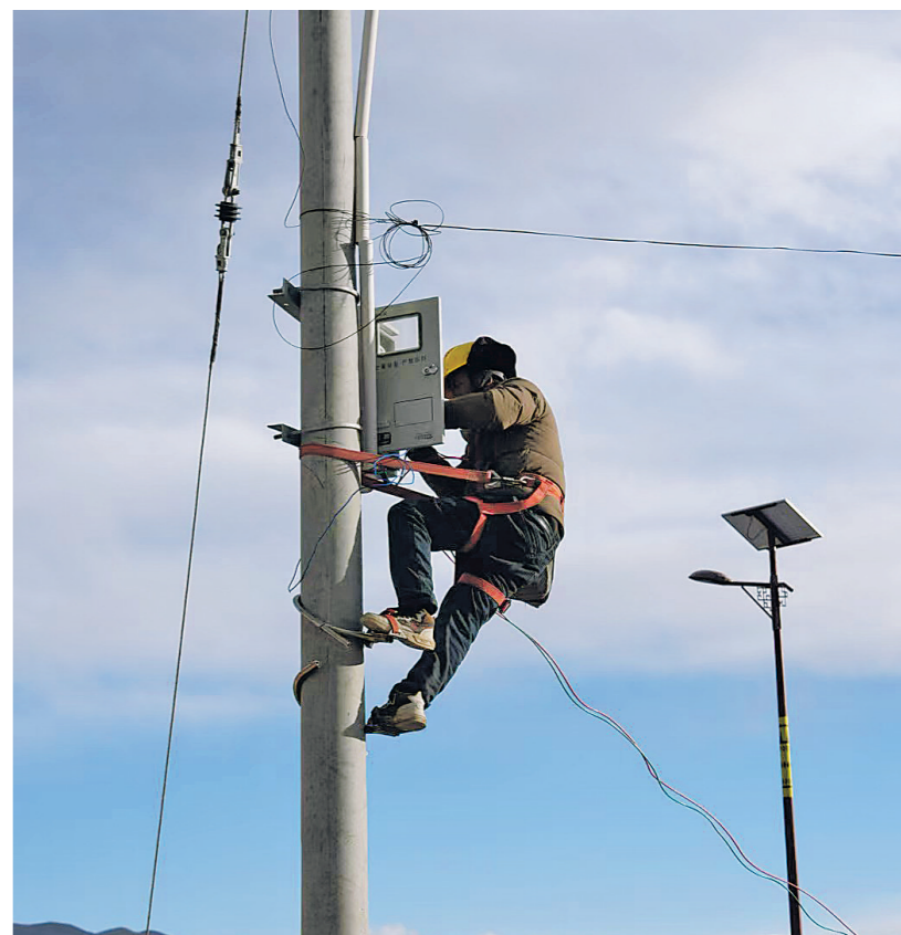
1月7日,在定日县长所乡古荣村,工作人员在抢修供电线路。
