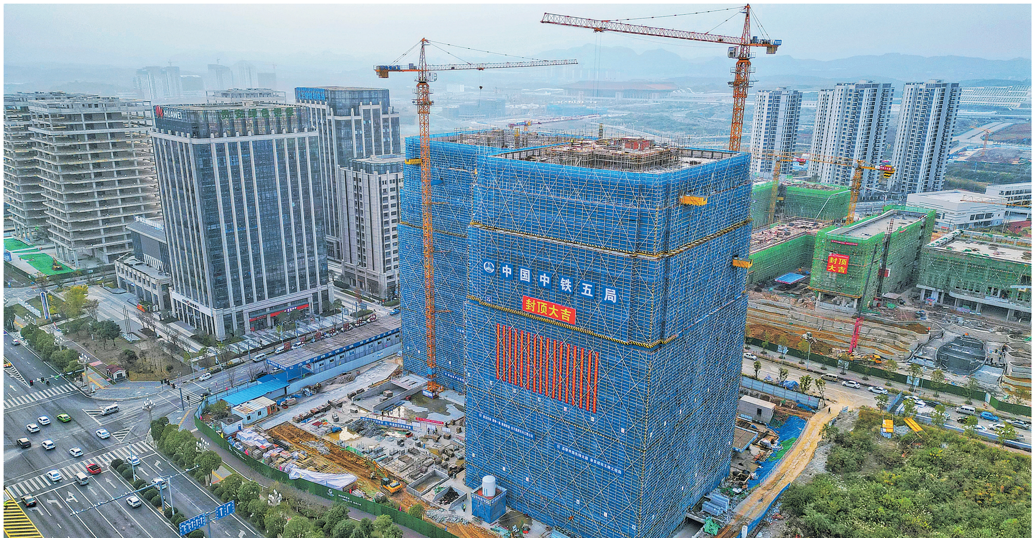
位于贵阳大数据科创城的贵安新区上海张江软件产业园A区项目建设现场(2024年12月28日摄)。
