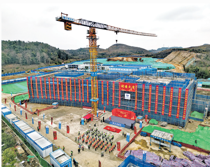
1月10日,交通银行贵安数据中心主体结构封顶现场。
