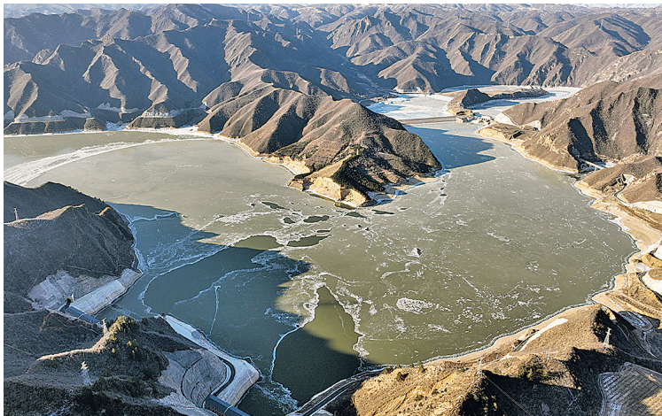
2024年12月31日拍摄的国家电网河北丰宁抽水蓄能电站下水库(无人机照片)。
