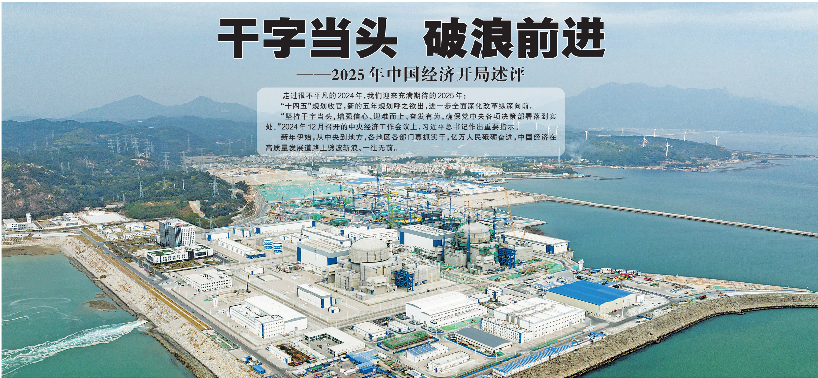
2025年1月1日拍摄的建设中的漳州核电站(无人机照片)。
