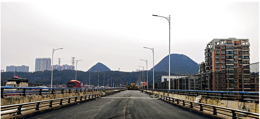
中曹司大桥维修工程施工现场。
