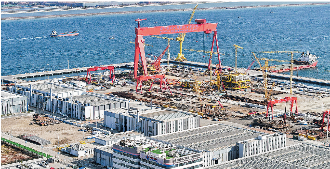
2024年10月30日拍摄的海油工程天津智能制造基地(无人机照片)。当日,海油工程天津智能制造基地二期工程在天津滨海新区正式投产,标志着国内首个海洋油气装备“智能工厂”全面建成。
