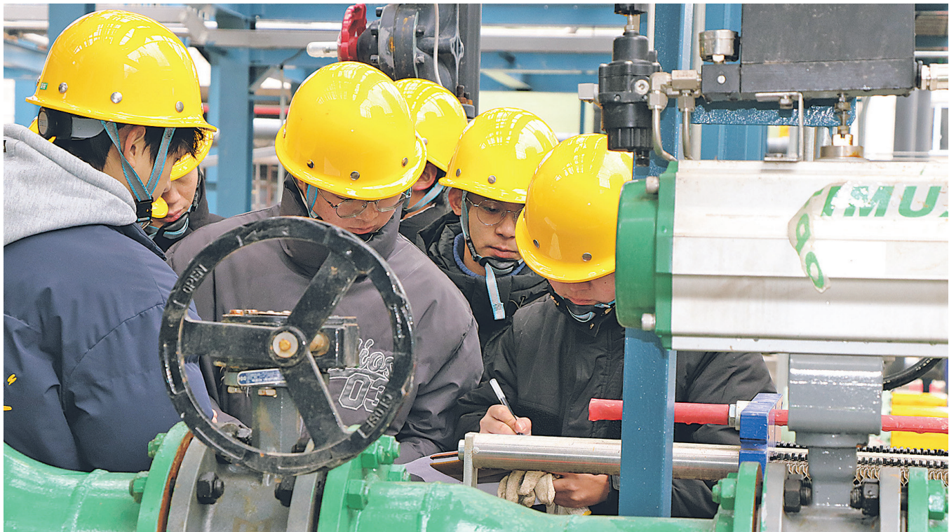
贵州聚力生化工有限公司一期10万吨氢氧化钾项目建设现场技术人员检查设备。
