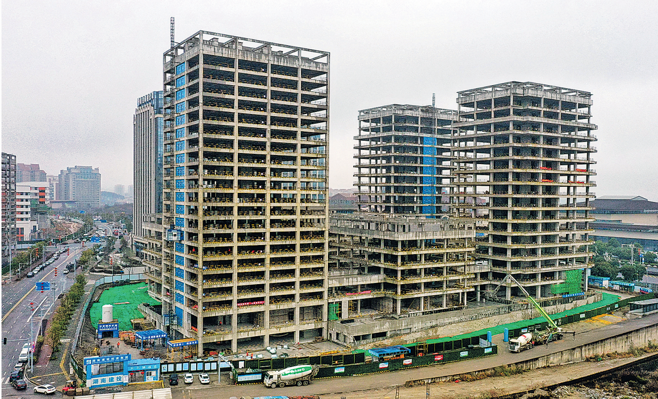
科创城·数字经济港项目A区施工现场。贵阳日报融媒体中心记者 石照昌 摄
