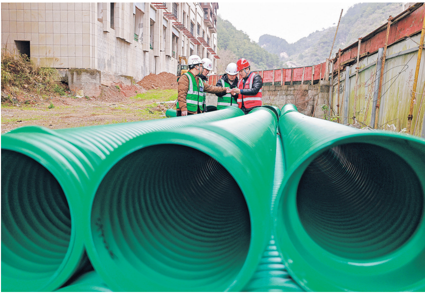
工人在项目现场抽查管道。 贵阳日报融媒体记者 周永 摄
