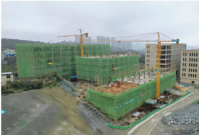
贵阳市云岩区电子信息产业园项目现场。 贵阳日报融媒体中心记者 梁超 摄
