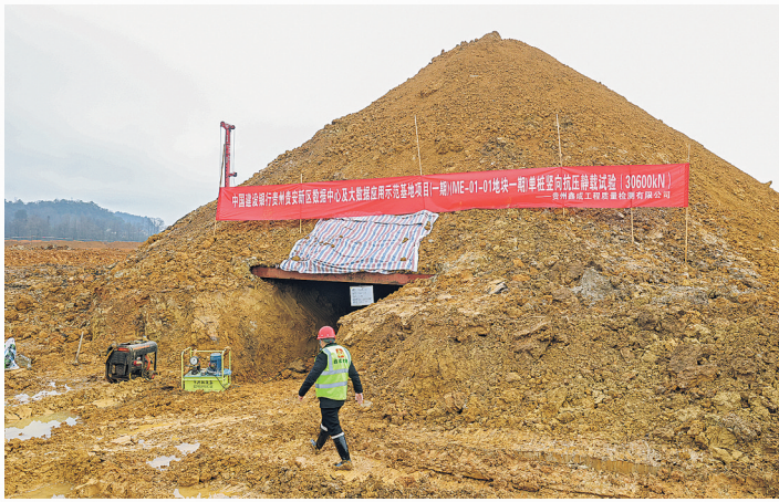
中国建设银行贵州贵安新区数据中心项目(一期)单桩竖向抗压静载试验现场。 贵阳日报融媒体中心 石照昌 摄
