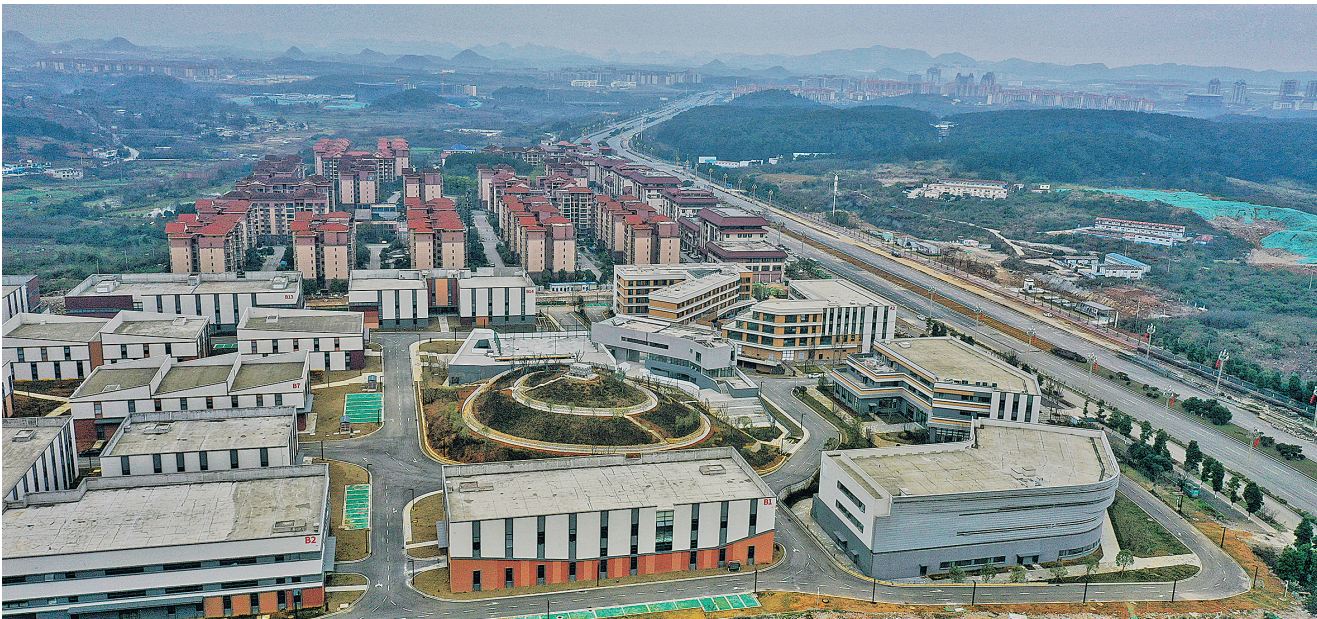
俯瞰“东数西算”贵安新区算力产业集群配套项目。 贵阳日报融媒体记者 石照昌 摄
