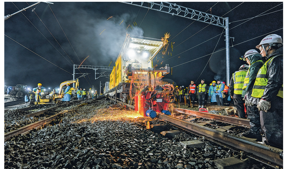
沪昆铁路至安六高铁联络线工程钢轨焊接作业现场。中国铁路成都局集团有限公司/供图
