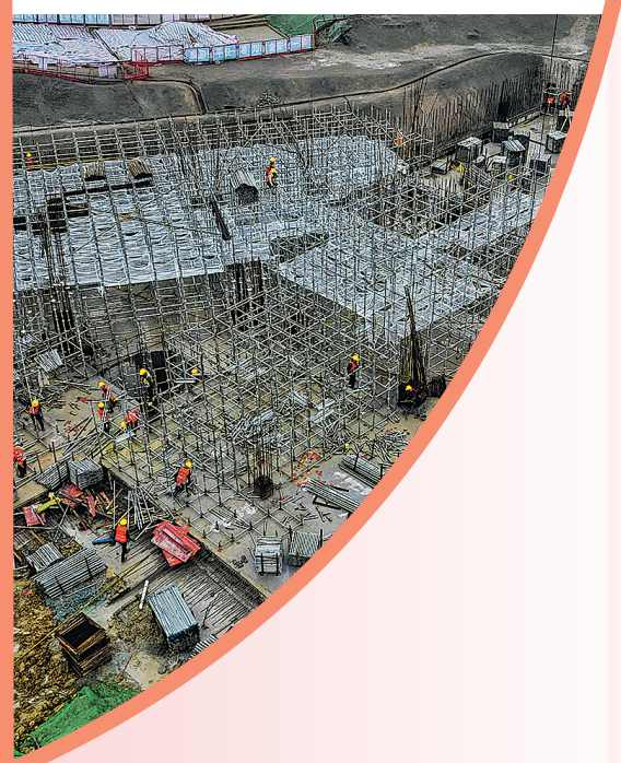
▲北京积水潭医院贵州医院二期项目现场。
