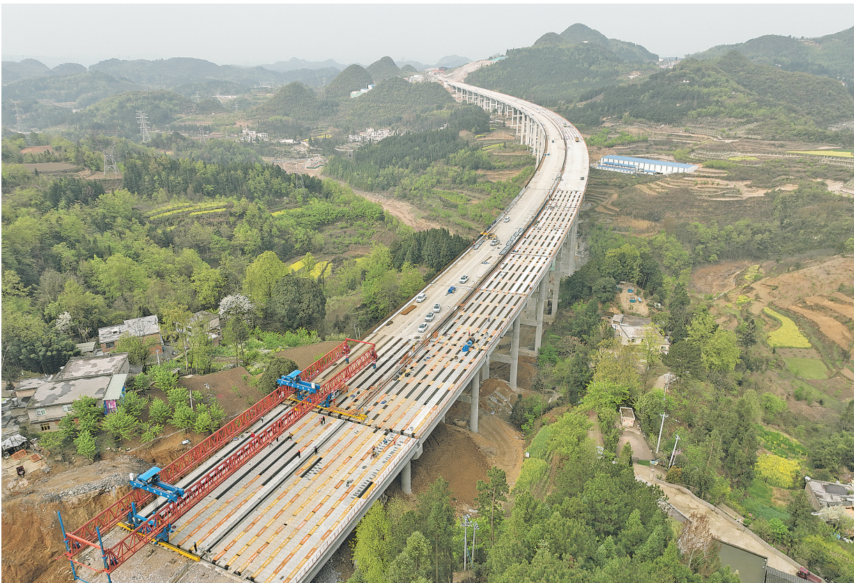
燕尾特大桥施工现场。 贵州高速集团/供图
