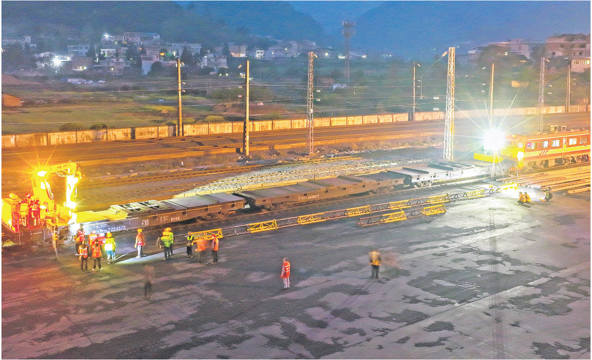
工作人员在铁道上进行集中修施工。
