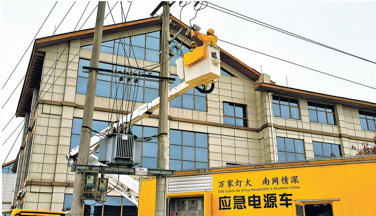
贵安供电局工作人员在实施发电车转供电作业。
