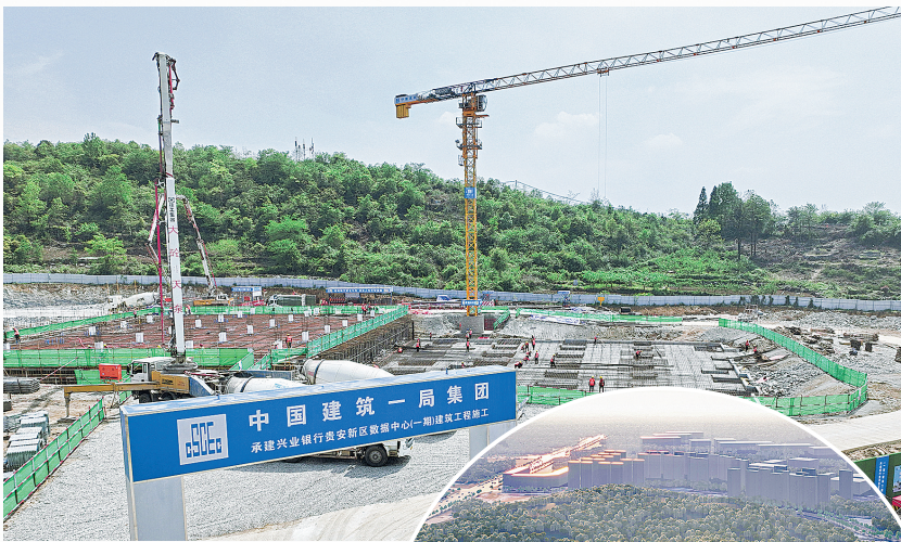
▲兴业银行贵安新区数据中心(一期)项目建设现场。
