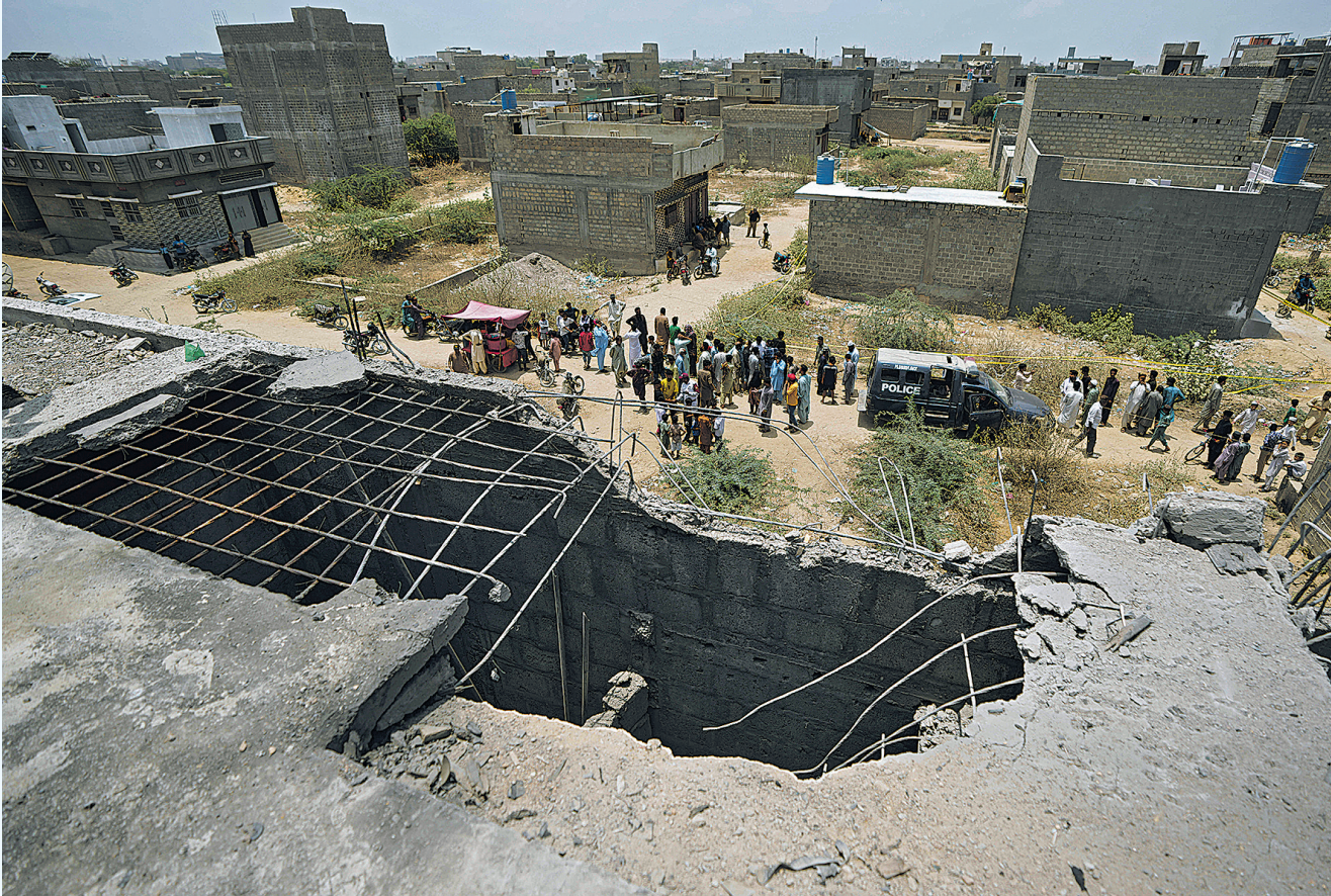
5月8日在巴基斯坦卡拉奇拍摄的一处印度无人机袭击中受损的房屋。
