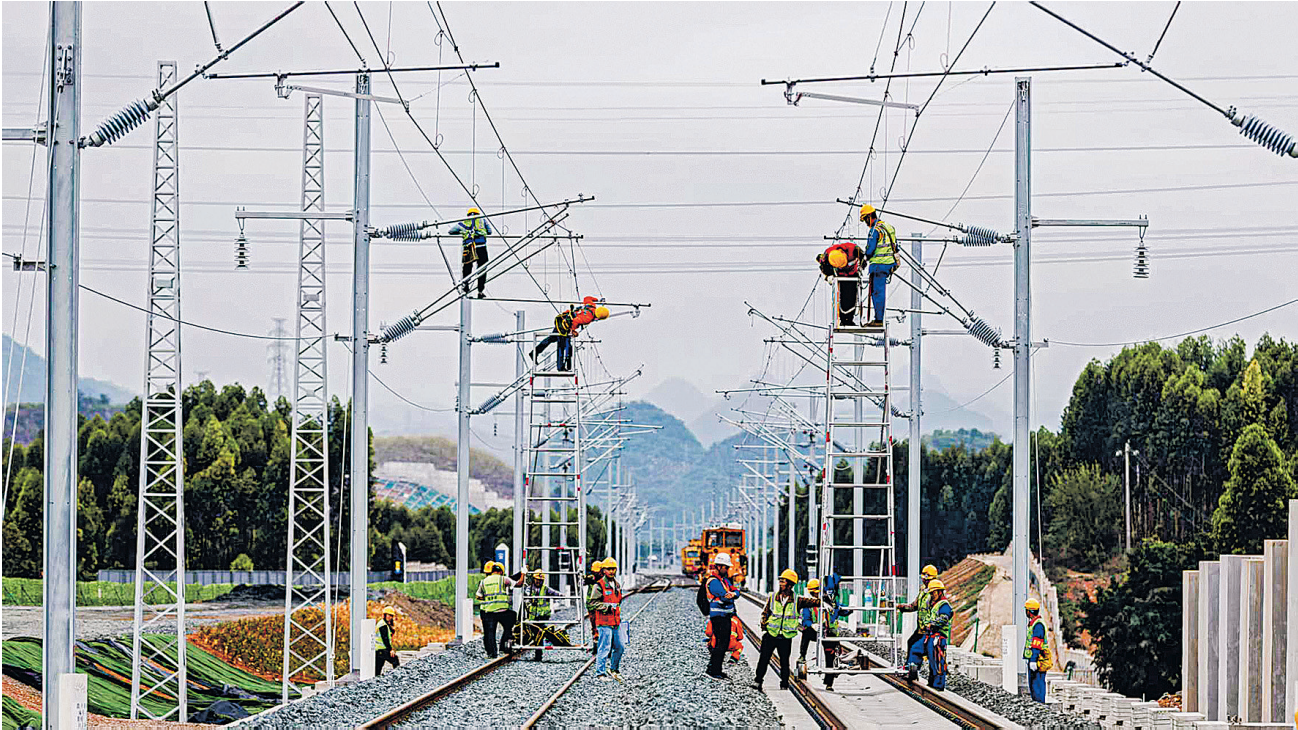
验收组正在查看盘兴高铁接触网首件工程。
