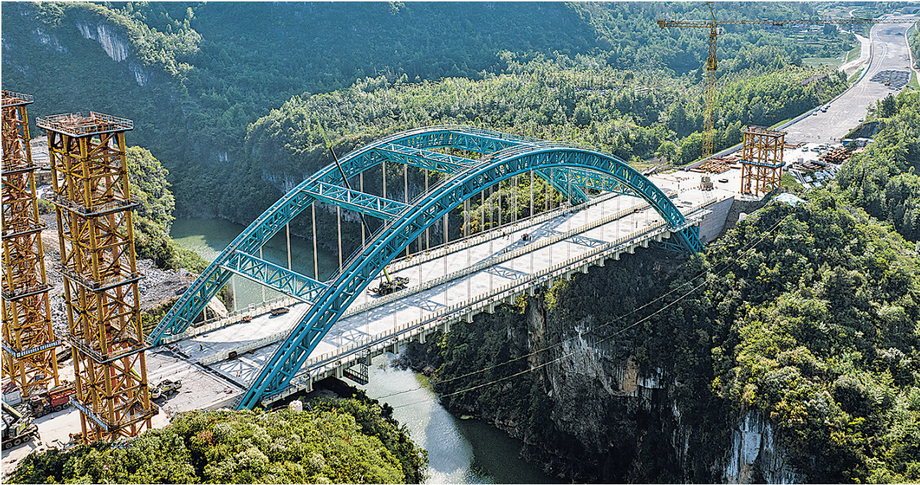
主体结构已建设完成的贵平高速拉密河大桥(5月13日摄,无人机照片)。 新华/传真
