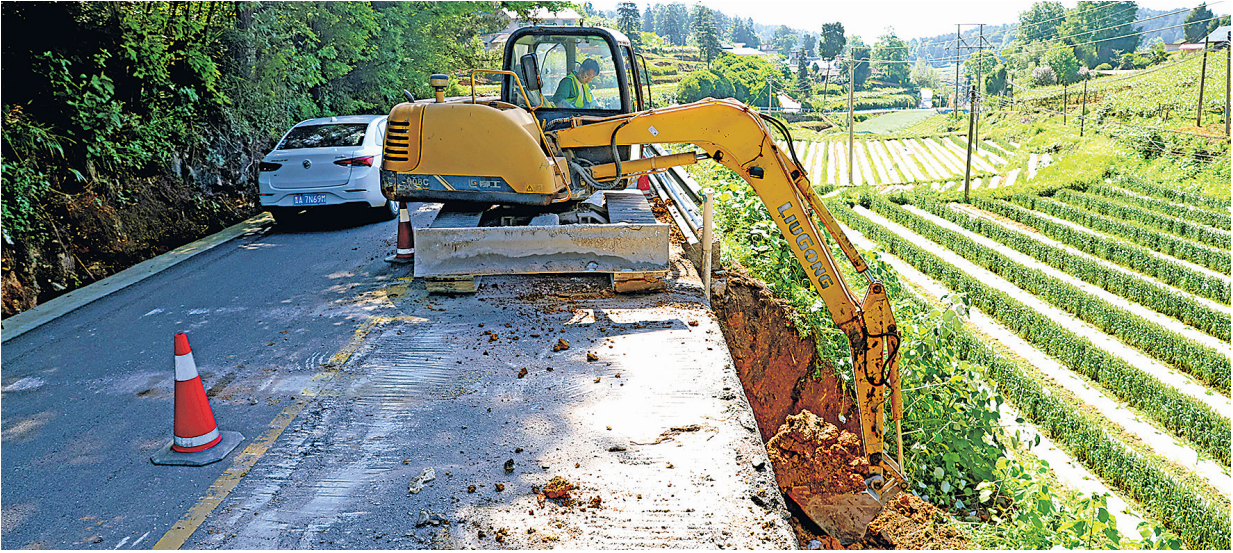
施工人员修复S101贵狮线路基挡墙。贵阳公路管理局/供图
